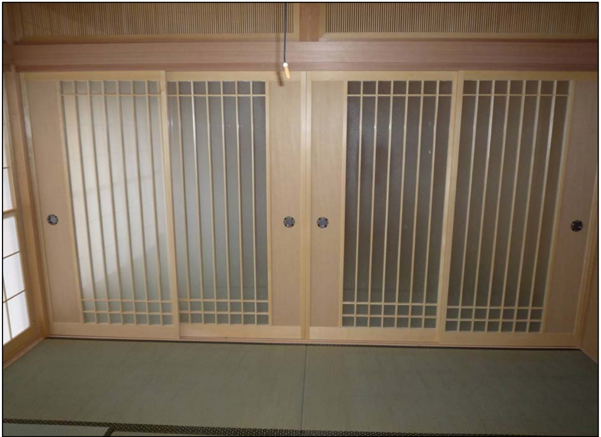
両面組子戸 下部:ヒバ突板 材質:米ヒバ
