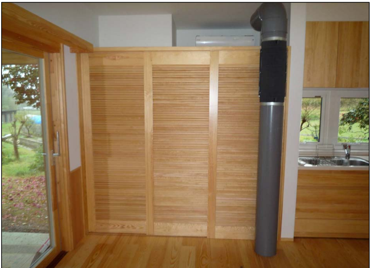
3本引き違いルーバー戸 材質:パイン 取っ手レス加工
