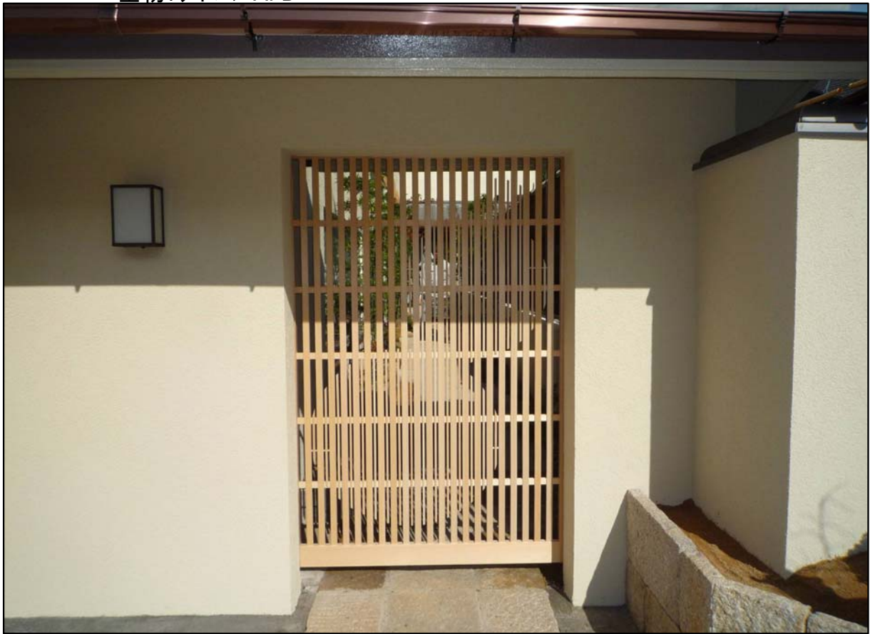
組子格子戸(瓢箪) 片引き吊り戸 材質: 桧 金物: アトム AFD
