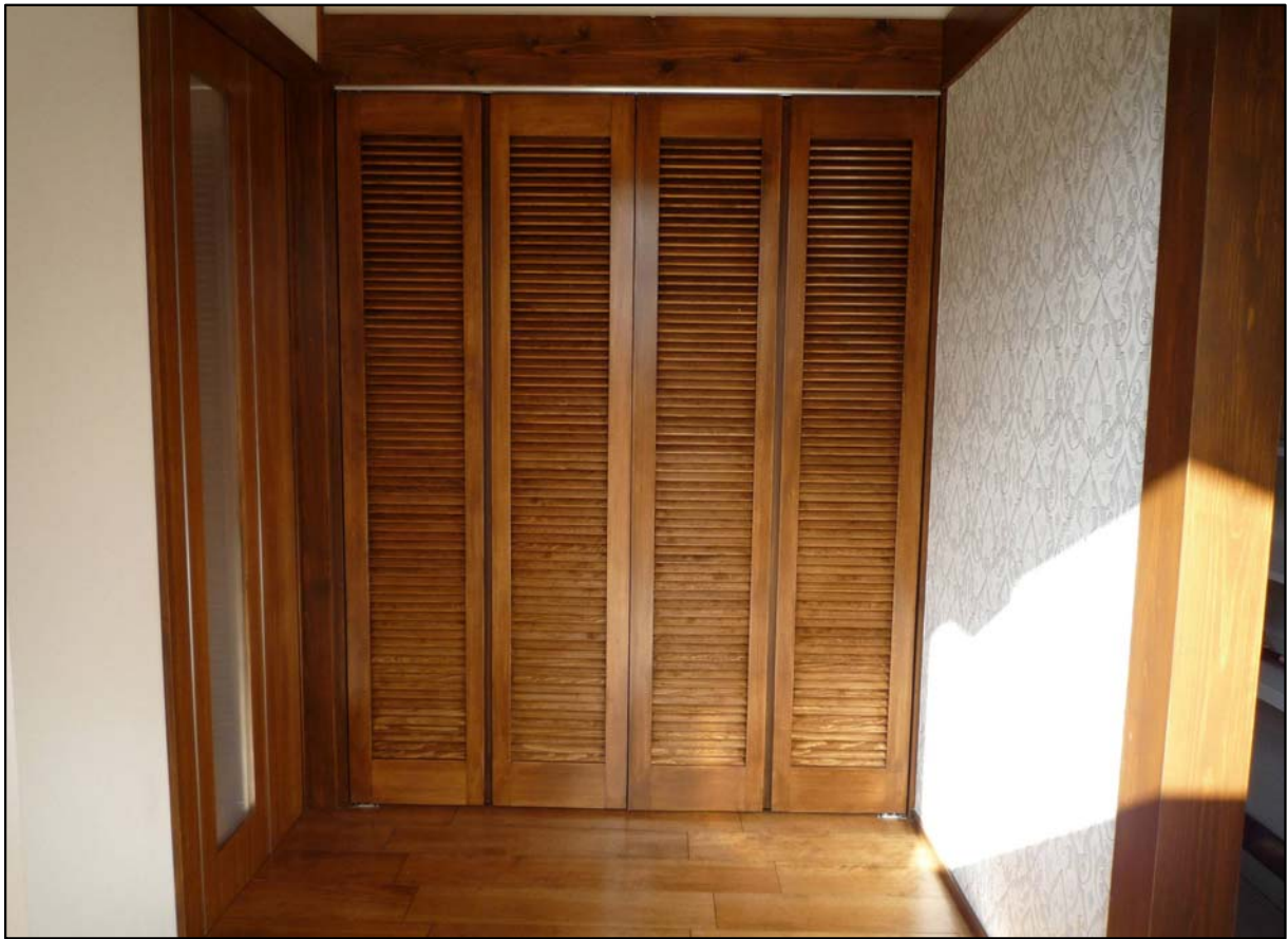
3本引き違いルーバー戸 材質:パイン 取っ手レス加工
