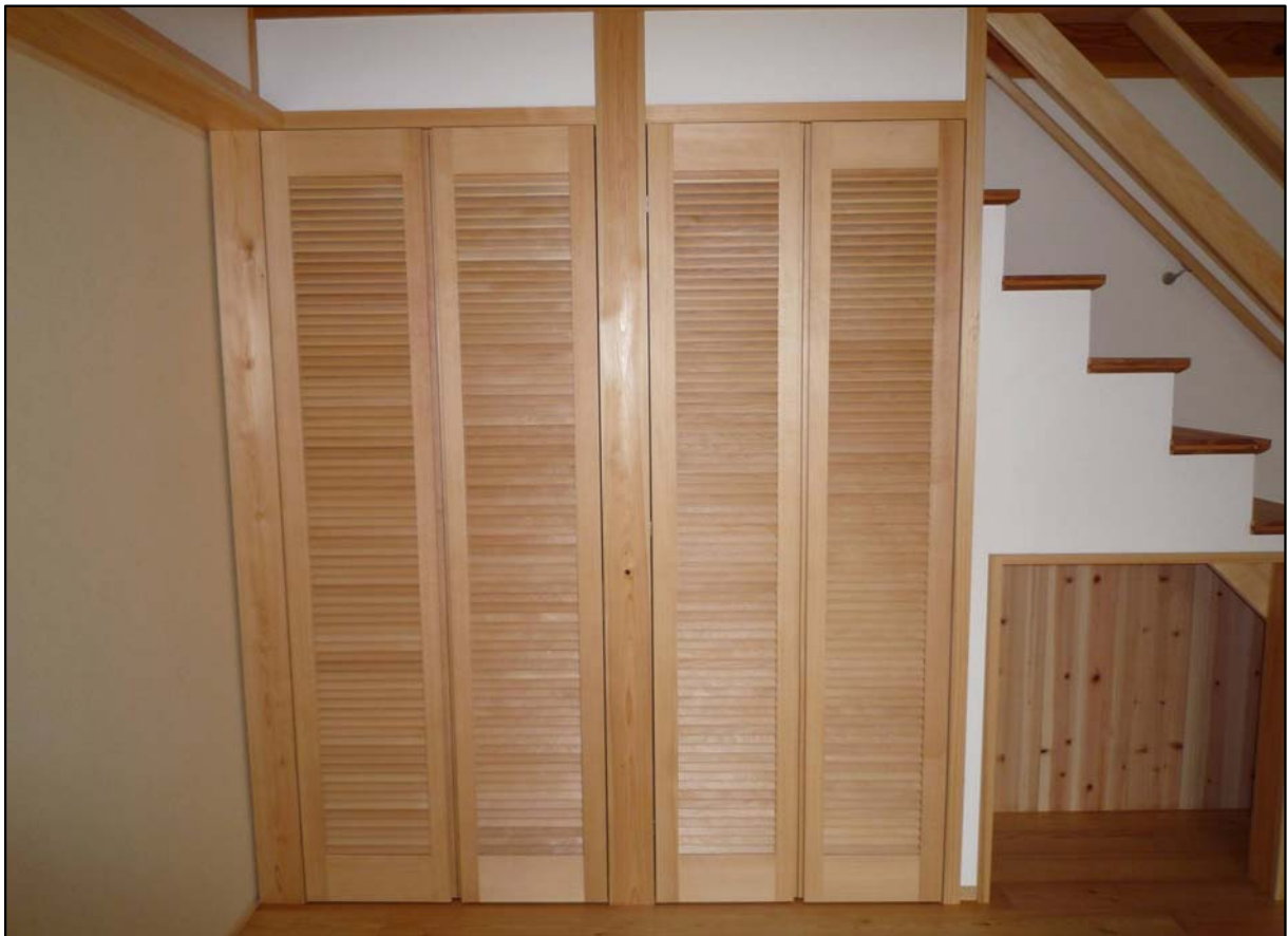
両開きルーバー戸 材質:スプールス 取っ手レス加工
