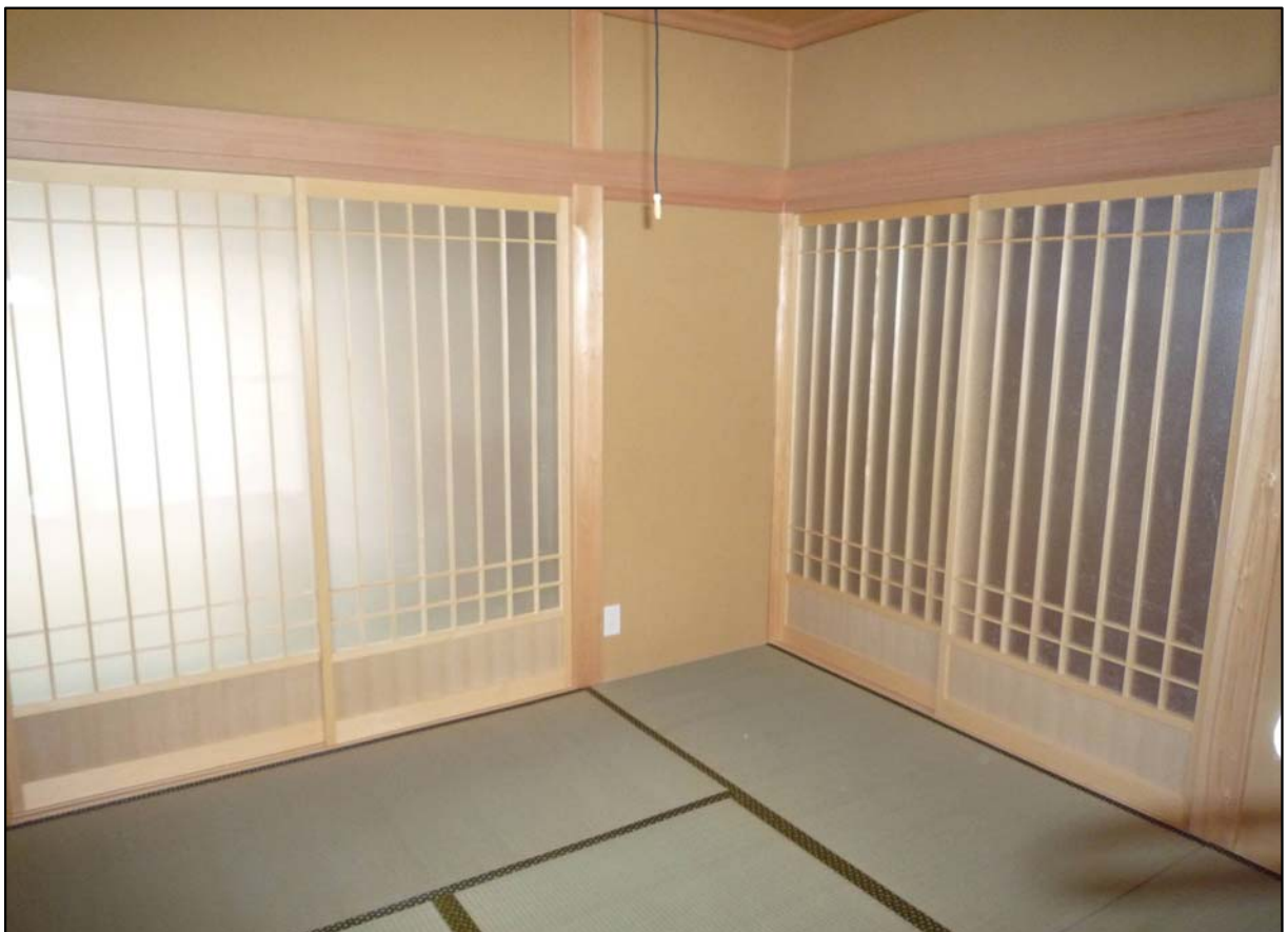
両面組子戸 下部:ヒバ突板 材質:米ヒバ
