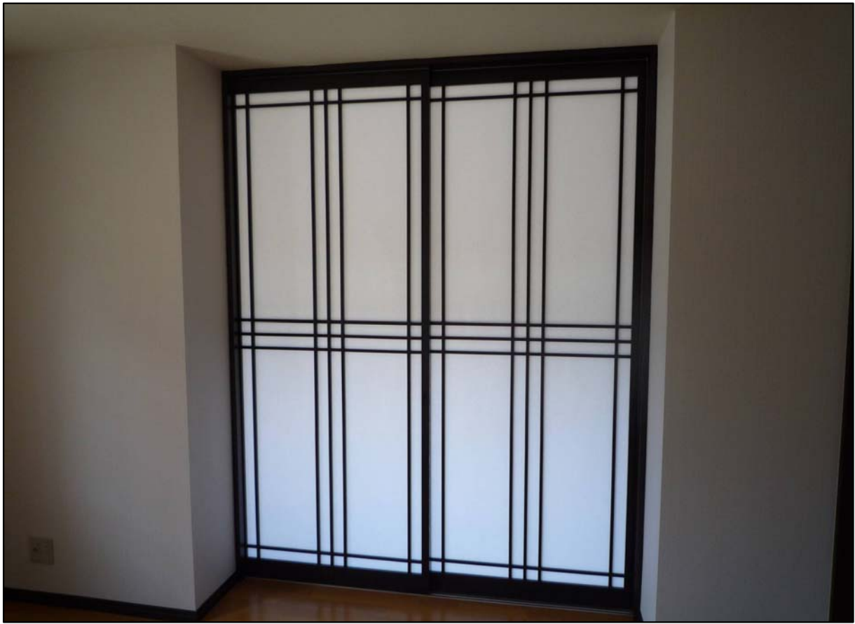
両開きルーバー戸 材質:スプールス 取っ手レス加工
