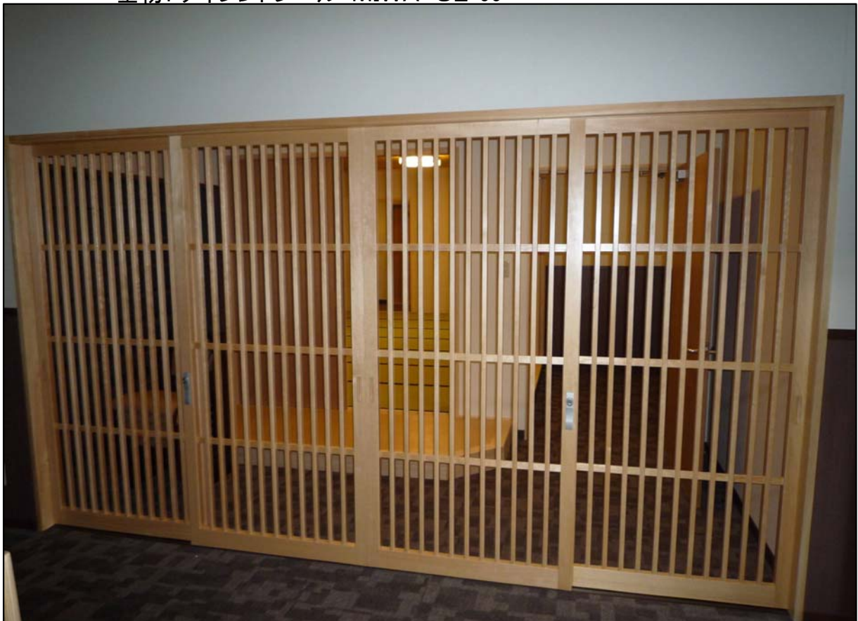
框格子戸 4本引き違い 材質:スプールス 金物:サイレントレール・MIWA SL-99
