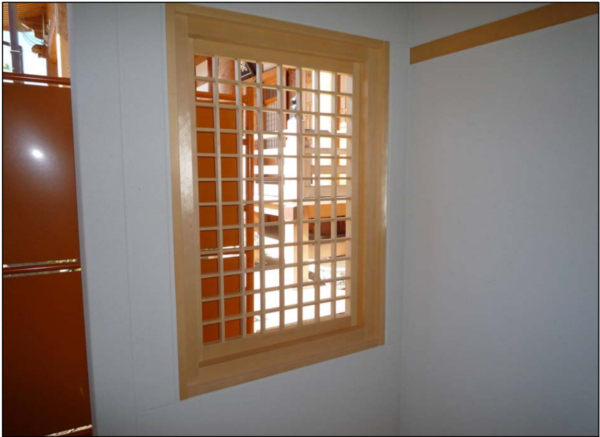
框格子戸 4本引き違い 材質:スプールス 金物:サイレントレール・MIWA SL-99
