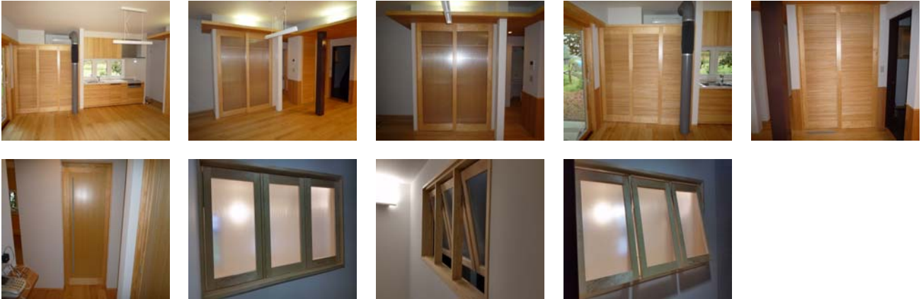
K邸 リフォーム工事(可児市 個人住宅) H27.04 木製建具工事
