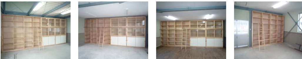
K組 改修工事（坂祝町 オフィス） H26.12 木製建具工事
