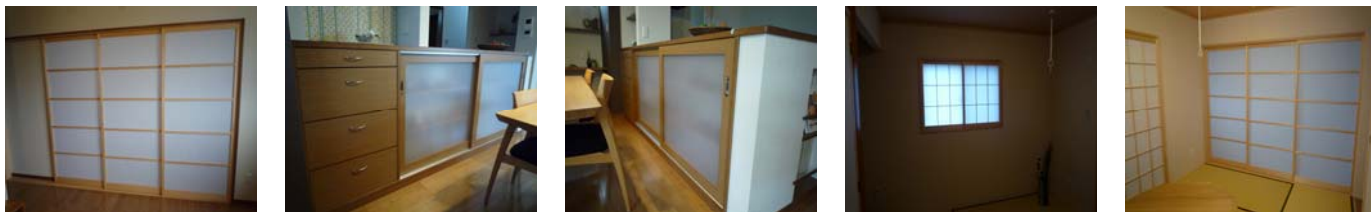
H邸 新築工事(関市 個人住宅) H25.06 木製建具工事
