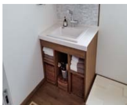
I邸 新築工事(各務原市 個人住宅) H25.07 木製建具工事・木製家具工事
