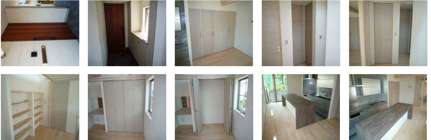
H邸 新築工事(岐阜市 個人住宅) H22.07 木製建具工事
