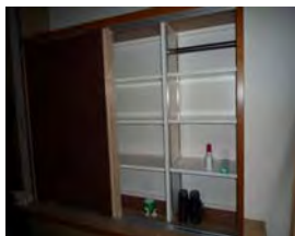
M邸 リフォーム工事(可児市 個人住宅) H20.11 木製建具工事
