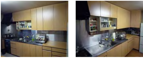
K邸 リフォーム工事(関市 個人住宅) H22.07 木製家具工事
