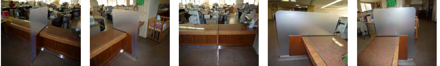
M公民館 改修工事(各務原市 公共施設) H21.02 木製建具・家具工事
