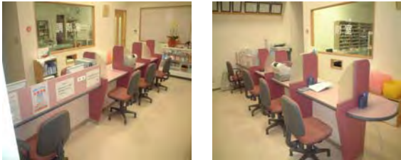
T邸 リフォーム工事(富加町 個人住宅) H17.07 木製建具工事
