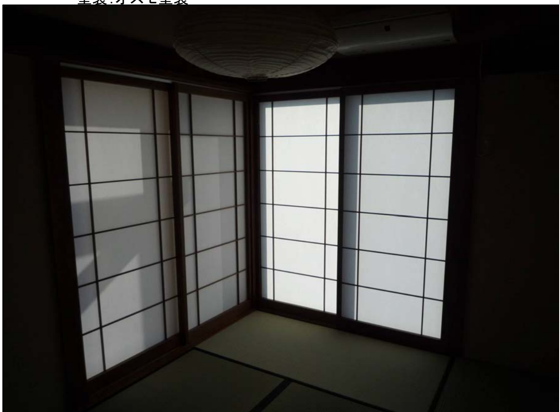
荒間障子2本引き込み×2 材質:スプールス 塗装:オスモ塗装
