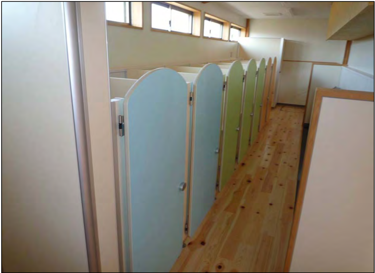
子供用 トイレブース 子供扉:メラミン化粧合板 その他 ポリ合板 SUS幅木 アルミエッジ
