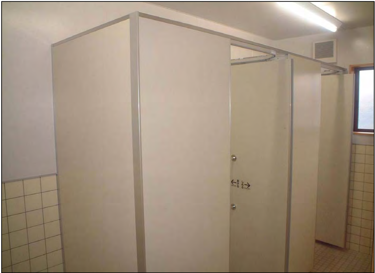
トイレブース(アールムーブドア) ポリ化粧合板 T型サポート アルミエッジ
