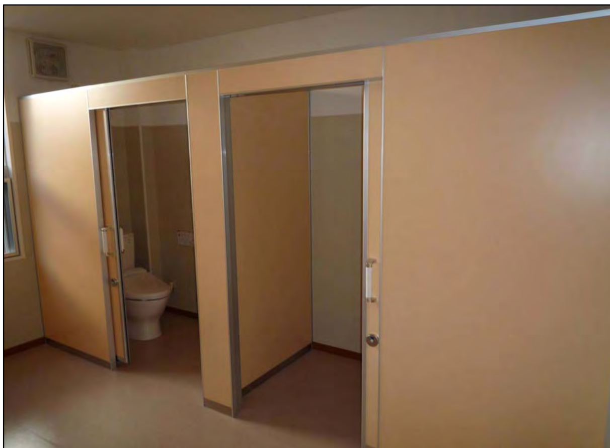
トイレブース メラミン化粧合板 SUS幅木 アルミエッジ
