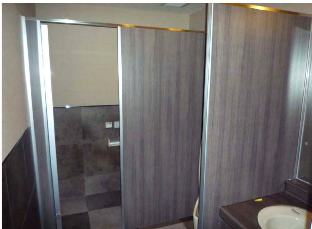
トイレブース メラミン化粧合板 SUS幅木 アルミエッジ
