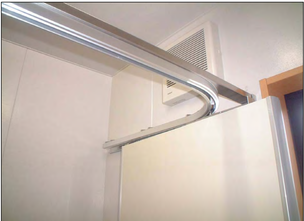
トイレブース(アールムーブドア) ポリ化粧合板 T型サポート アルミエッジ
