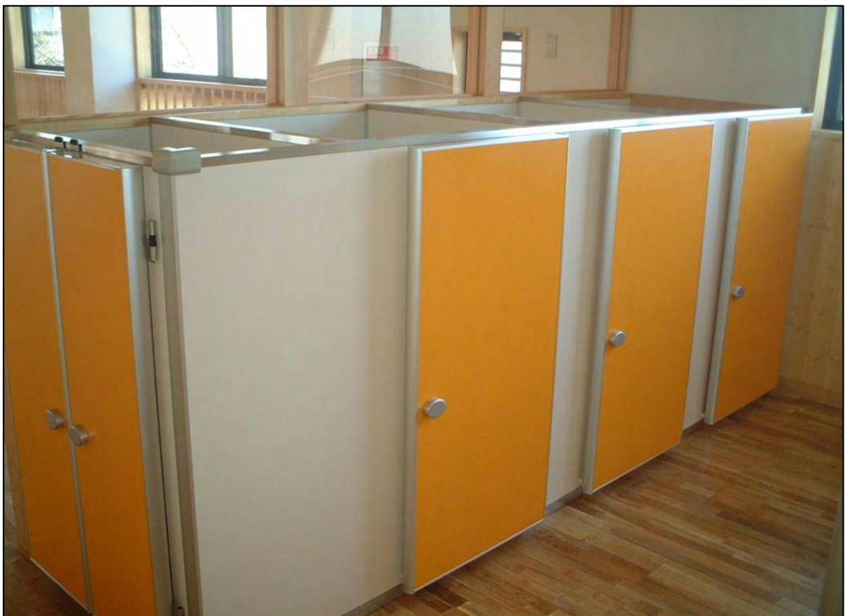
子供用 トイレブース 子供扉:メラミン化粧合板 その他 ポリ合板 SUS幅木 アルミエッジ
